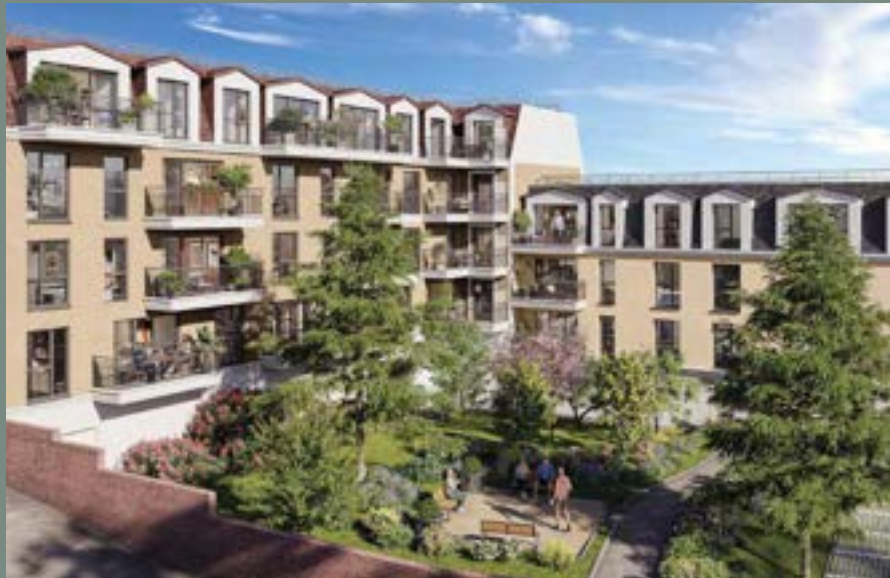
DÉPARTEMENT 91 SAINTRY Villa des Deux Cèdres
